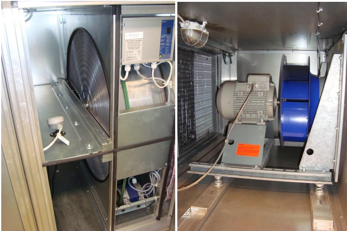
Kuva 2. Ilmanvaihtokoneen tarkistus sisältäpäin; huoltoluukut, tiivisteet, komponentit.
