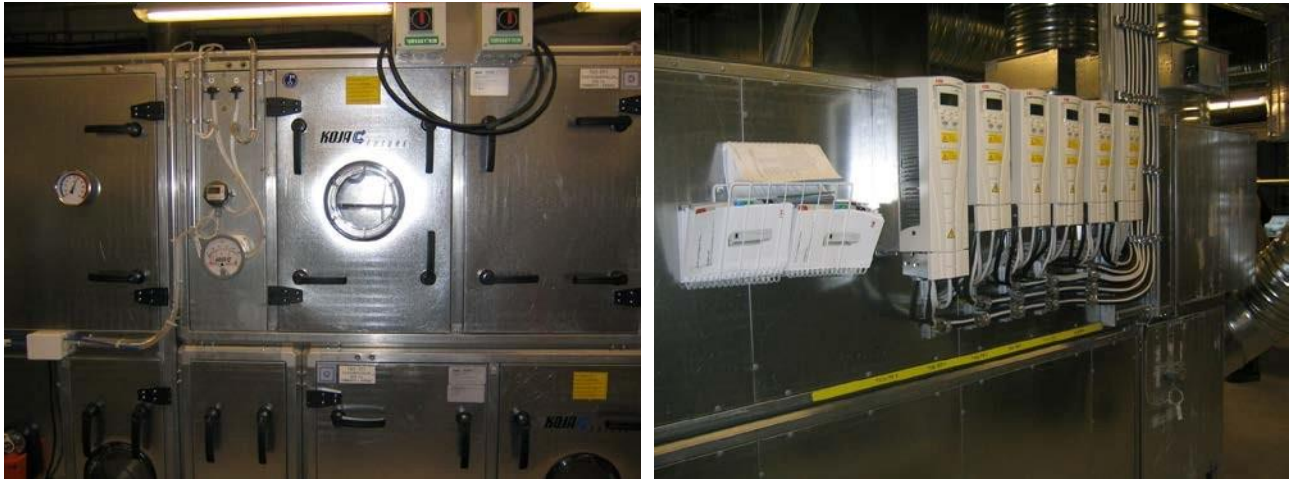
Kuva 1. Ilmanvaihtokoneen tarkistus ulkoapäin; vaipan kunto, osoittavat anturit ja taajuusmuuttajat.
