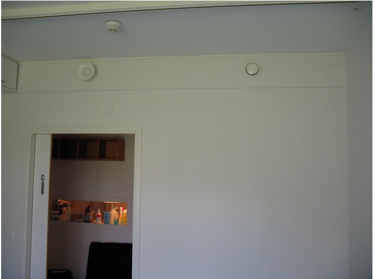
Kuva 1. Ilmanjakoa ja hajotuskuviota arvioitaessa on tarkastettava päätelaitteiden keskinäinen sijainti ja sopivuus huonetilaan.
