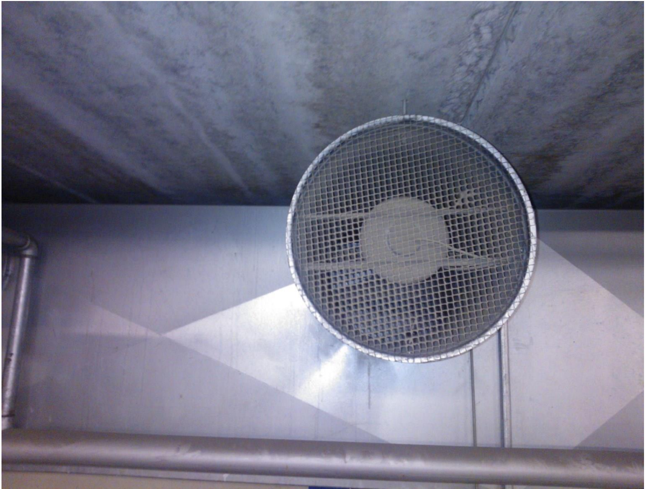
Kuva 7. Päätelaitteen ja siihen liitetyn mittauslaitteen toimintakyky on varmistettava säännöllisellä huollolla. Tämän mittauslaitteen tehdaskalibrointi ei ole käyttökelpoinen.
